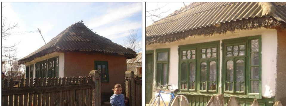
Jirlău. Casă de pe Strada Râmnicu Sărat, nr. 36 (foto 2010).
