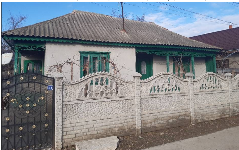
Jirlău. Casă de pe Strada Școlii, nr. 53 (înlocuire împrejurire), (foto 2024).
